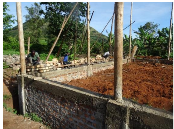
Der untere Teil des Gebäudes wird mit lokal gebrannten Ziegeln gemauert
