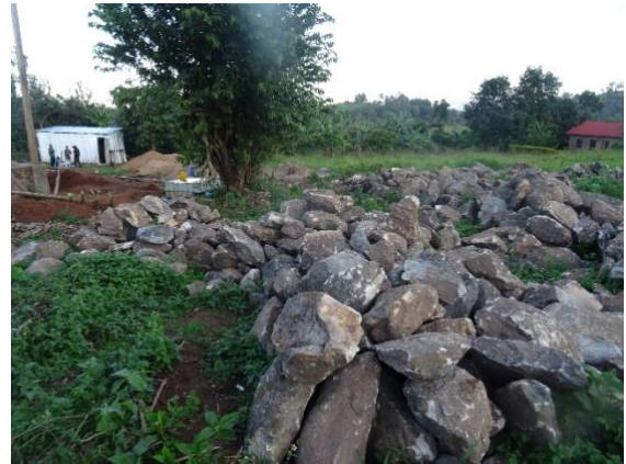
Steine für die Fundamentplatte des Speichergebäudes werden lokal gewonnen
