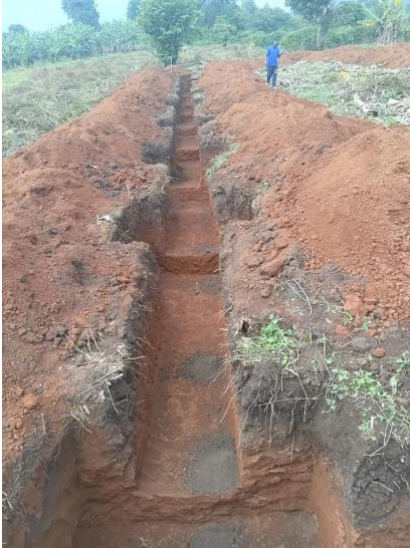
Fundamentgräben des Speichergebäudes
