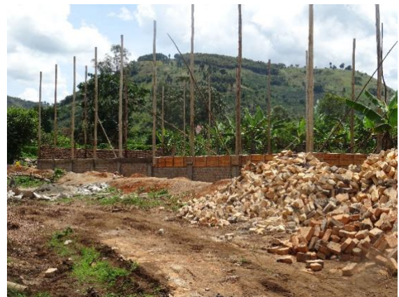
Der untere Teil des Gebäudes wird mit lokal gebrannten Ziegeln gemauert
