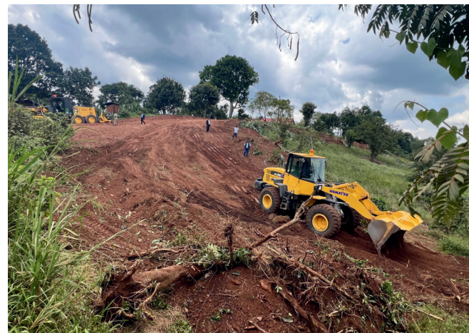
Vorbereitungen zum Bau der neuen Ave-Maria Schule in Kitagwenda
