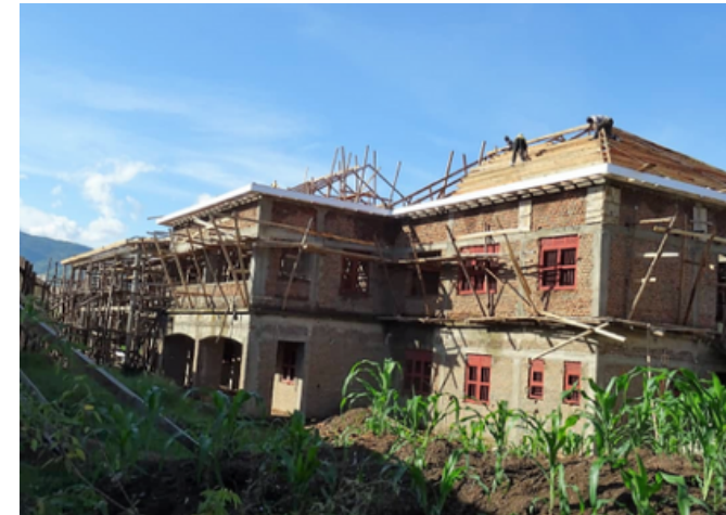
(Foto: das neue Ambulanzgebäude im April 2021)
