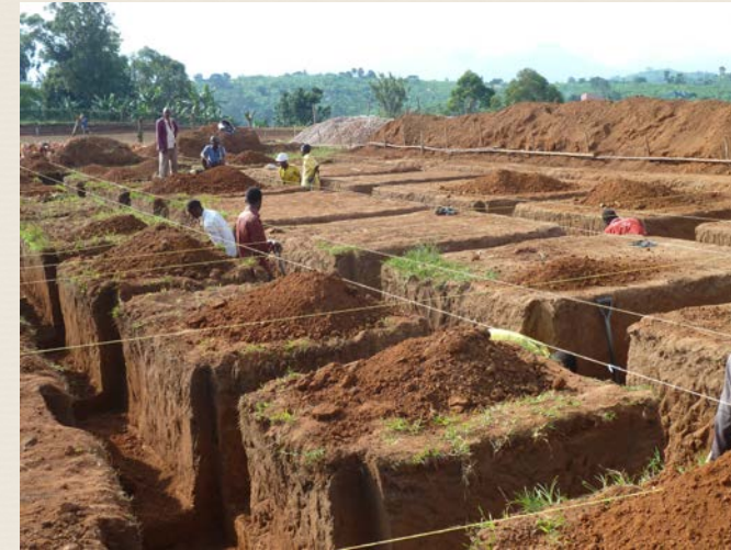
Das Fundament ist immer Ausdruck von Stabilität
