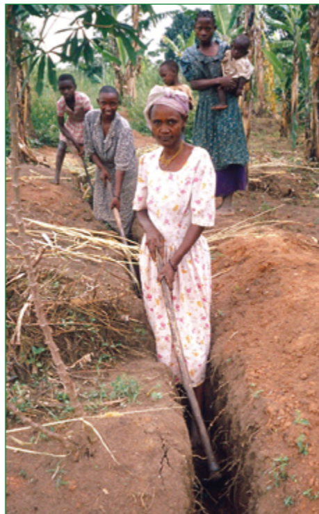
Die Anwohner bereiten die Gräben für die Trinkwasserleitungen vor.
